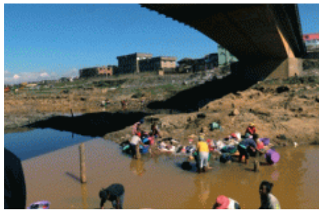
Des activités d'extraction de sable ont été entreprises illégalement, sous le pont d'Ampasika.
